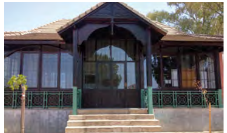
Vista de la Biblioteca Municipal
